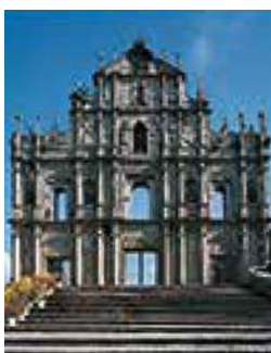
De machtige gevel van de Ruinas de São Paulo
