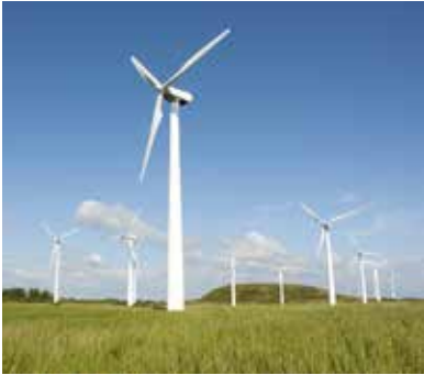
Windturbines aan de westkust van Denemarken, waar de situatie ideaal is voor het produceren van schone energie
